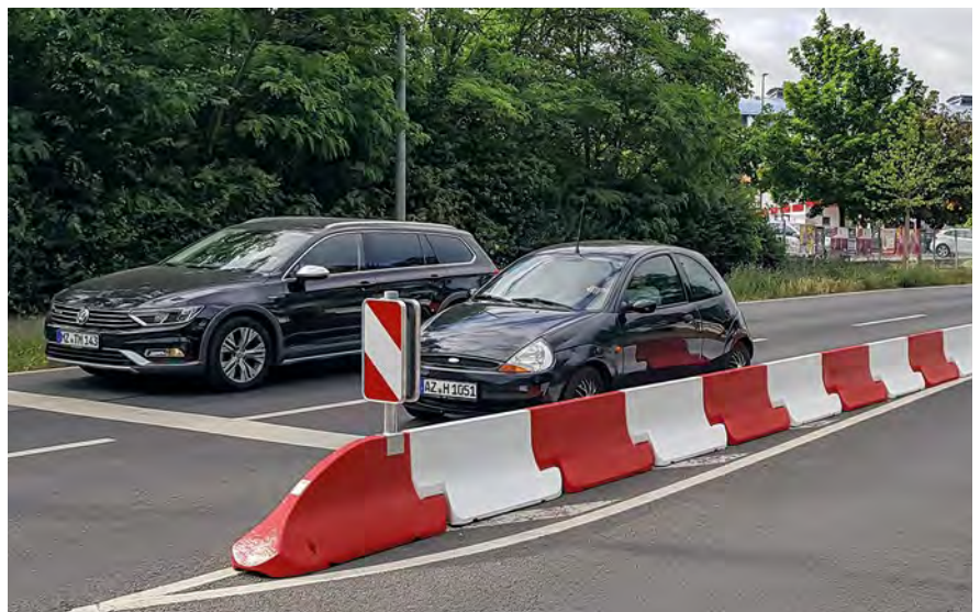
Nach dem Einsatz sind die Elemente ohne großen Aufwand wieder demontierbar und an anderer Stelle einsetzbar.
