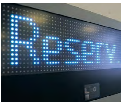
LED-Anzeige in der Tiefgarage der MHPArena.
