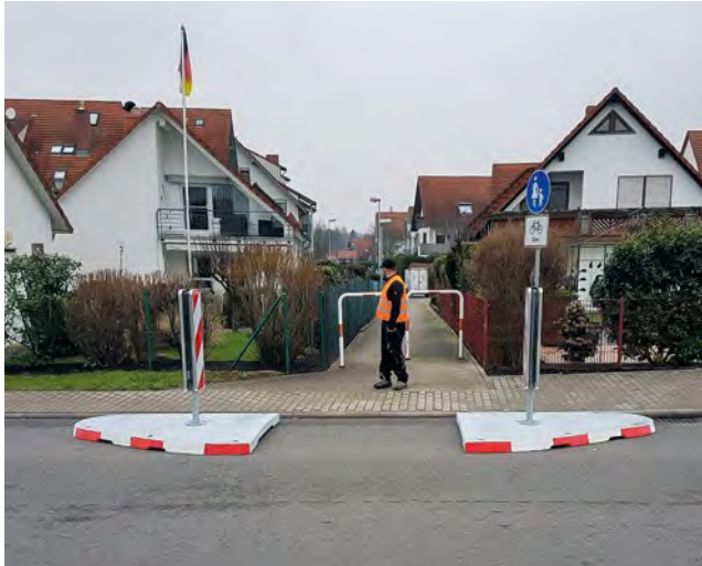
Verkehrsberuhigung und Überquerungshilfe in einem.
