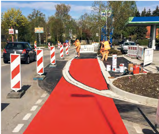
PlastiRoute RollPlast ist besonders geeignet für großflächige Beschichtungen wie Fahrradwege, Spielplätze oder Behindertenparkplätze.
