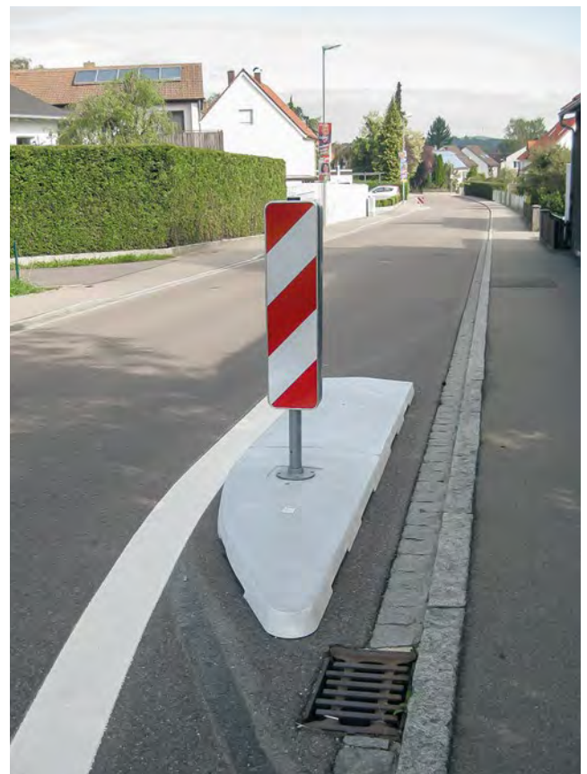
Die seitliche Einengung mit einer Breite von lediglich 0,80 m eignet sich auch für schmale Straßen.
