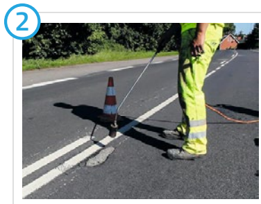
2 Mit einem Gasbrenner den Einsatzbereich vorheizen.
