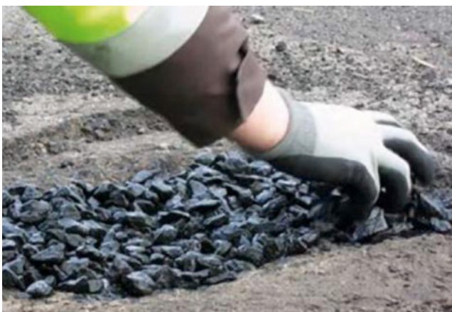
Loch vollständig mit AggreFill™ befüllen
